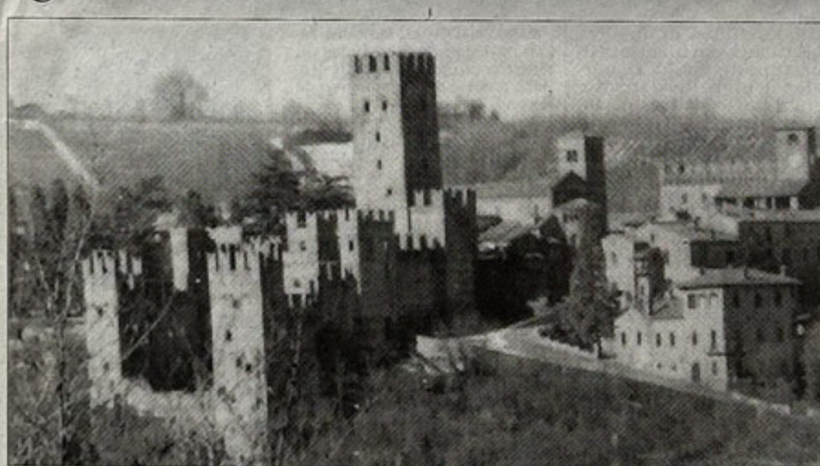
CASTELLARQUATO - Una veduta della Rocca Viscontea costruita nel 1300.
